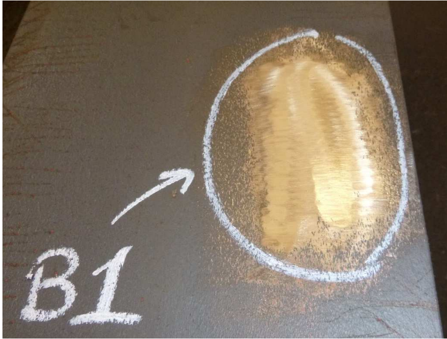
Figur 6-5 Exempel på yta efter bearbetning med vinkelslip med kornstorlek 60 och 120.
