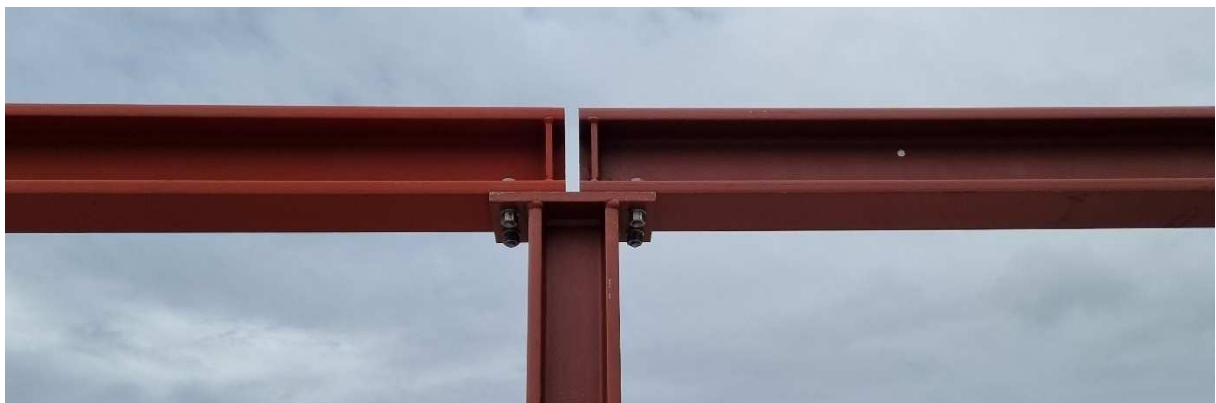
Figur 2-5 Delad bärlina med skarv över mittstödet.
