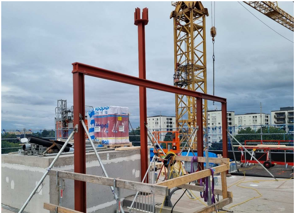
Figur 2-4 Konstruktion av återbrukade profiler efter montage
